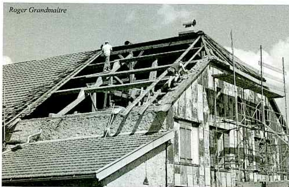
Démontage de la 1 ère partie du toit
